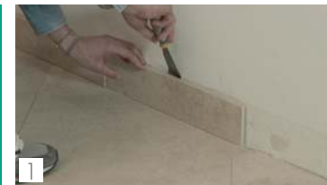
1 Eliminare il battiscopa Remove skirting
