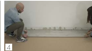
4 Posare il pavimento senza fuga Lay the floor tiles with close joints
