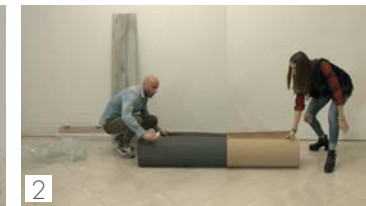
2 Stendere il tappetino Lay the underlayer
