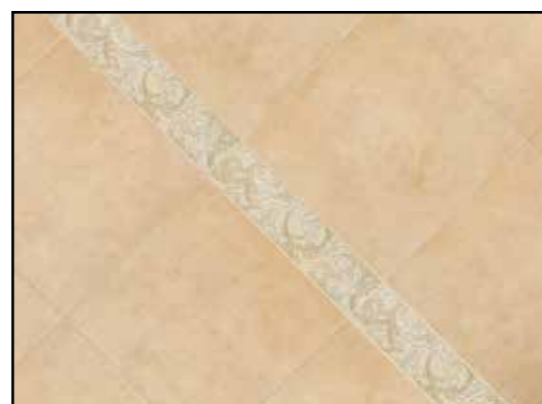
Укладка 9 / Posa 9 / Installation 9
