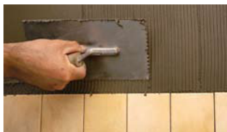
Нанесение LITOKOL K17 зубчатым шпателем
